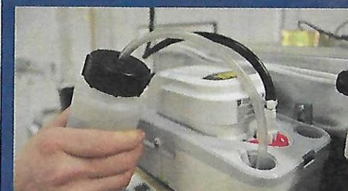
Aspen Pumps propone una nuova pompa con serbatoio per la rimozione della condensa dagli impianti di condizionamento ■ pag 52
